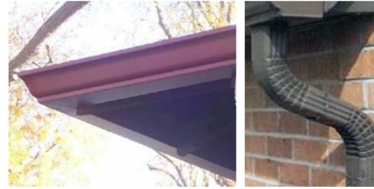
METAL GUTTER AND DOWNSPOUT
