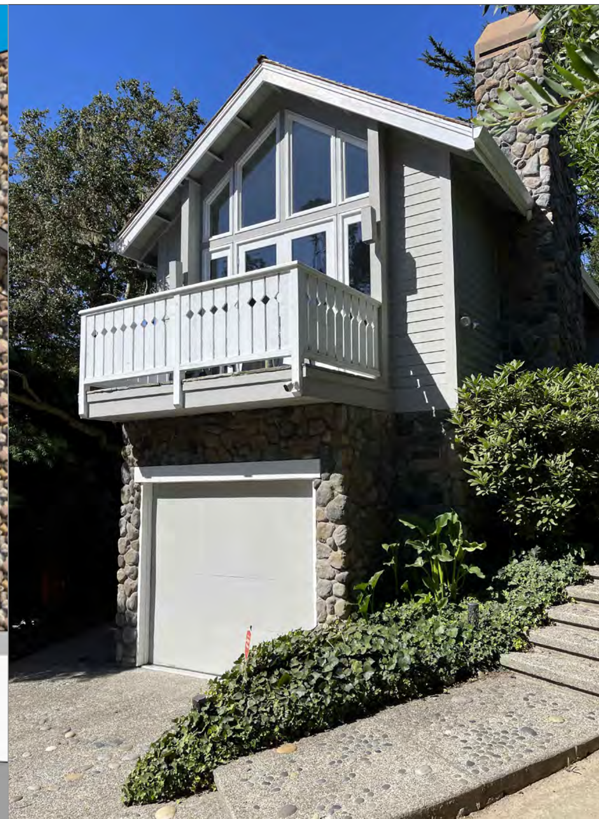
Front View of Existing Balcony (N.T.S.) 06
